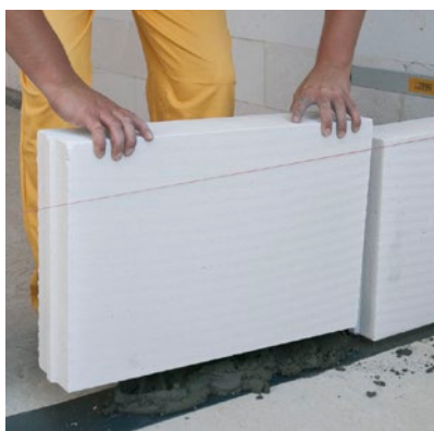
Pieliekam kārtējo bloku, neaizpildot vertikālās šuves – tās aizstāj sistēma „spunde – grope”.
