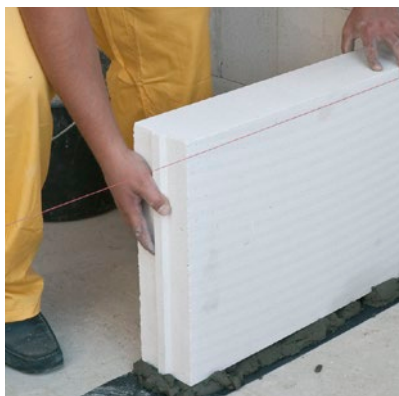
Pirmo bloku slāni veidojam uz tradicionālās javas, paturot prātā hidroizolāciju.
