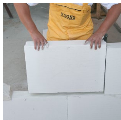
Līmējot kārtējo slāni, atceroties par vertikālo šuvju pārbīdīšanu.
