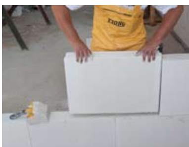
Līmējot kārtējo slāni, atceroties par vertikālo šuvju pārbīdišanu.
